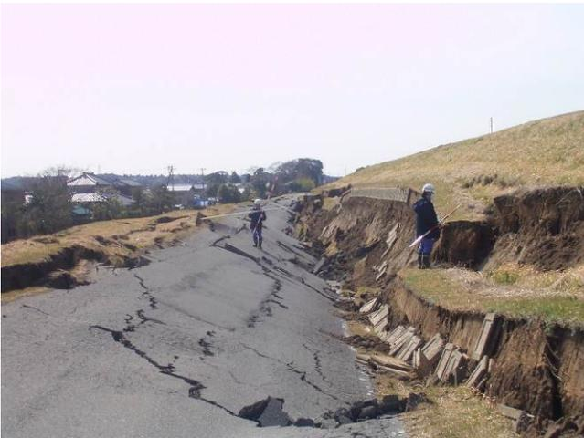
に示すように舗装面が傾斜しつつ沈下した。裏のり尻付近では堤体の表面がめくれ上がりつつ落下するように崩壊した箇所や裏のり尻部の基礎地盤が隆起した箇所、階段工に大きな変状が見られた箇所もあった。
