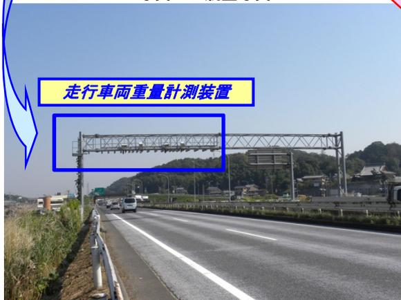
写真-2 走行車両重量計測装置（名古屋方面を望む）
