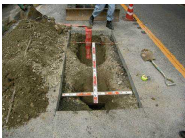
写真-1 緊急開削
