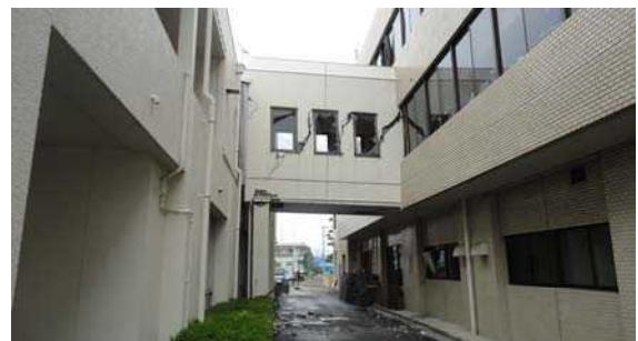
写真-8 渡り廊下の損傷
