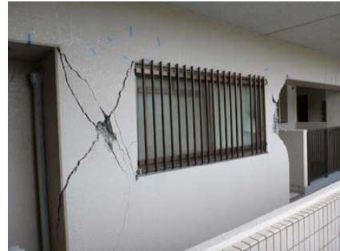
写真-6 方立壁の損傷
