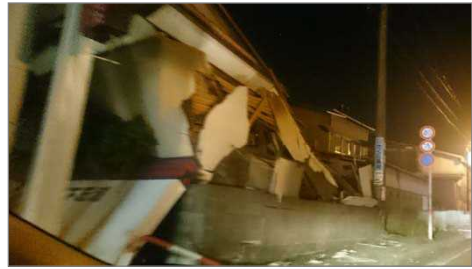
写真-5 益城町付近の被災状況(16日本震直後)
