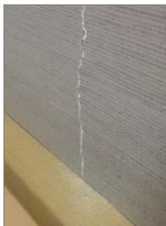
写真-4 宿泊した部屋の壁に入ったクラック
