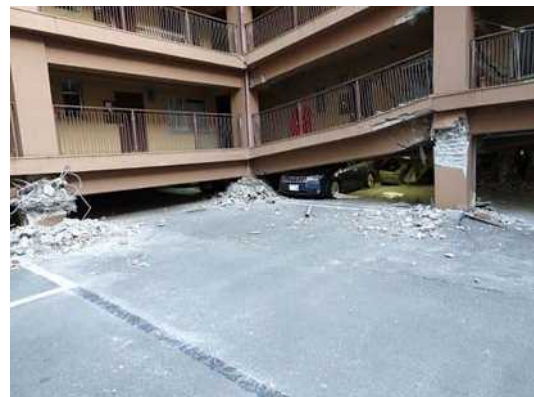
写真-13 ピロティ層の層崩壊
