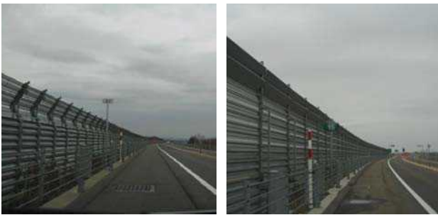
写真-1 吹き止め柵
