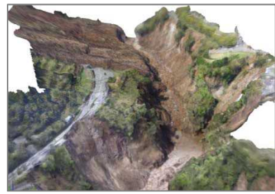
写真-12 ドローンの映像より作成した3Dモデル (阿蘇大橋崩落現場付近)
