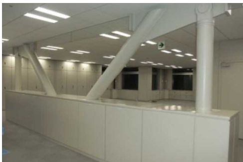
図-4 制振装置の設置状況
