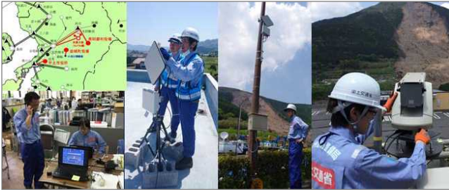
写真-14 i-RAS, 監視カメラ設置及び
