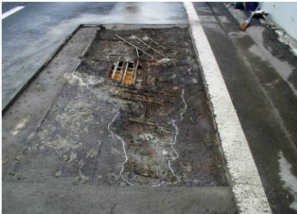
図-3 既設コンクリート床版の損傷
