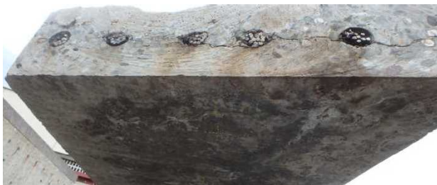
図-4 既設床版に発生した水平ひび割れ
