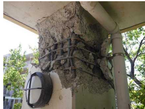
写真-2 1階柱柱頭部の被害
