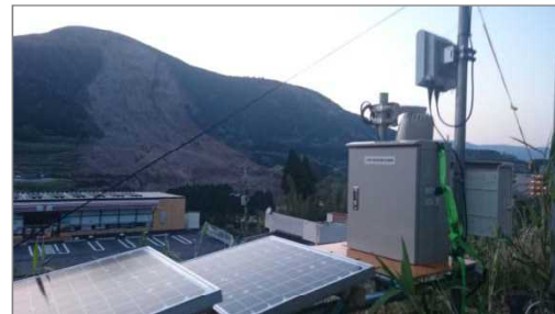
写真-16 太陽光パネルとバッテリーによるカメラ電源 (南阿蘇村・国道 5 7 号災害現場)
