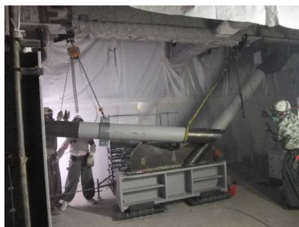
図-8 鉄骨部材の組み上げ過程
