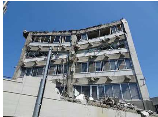
写真-12 局部破壊
