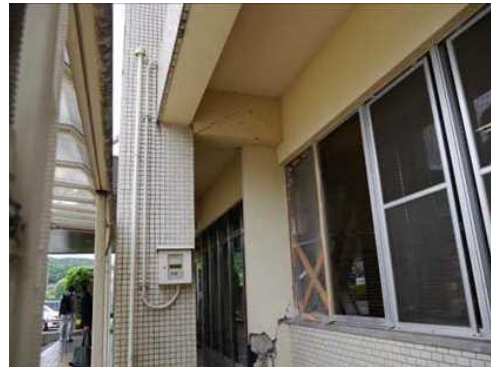
写真-11 短スパン梁のせん断ひび割れ
