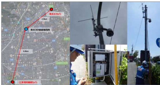
写真-15 公共 B B 及び監視カメラ設置状況 (熊本市内)
