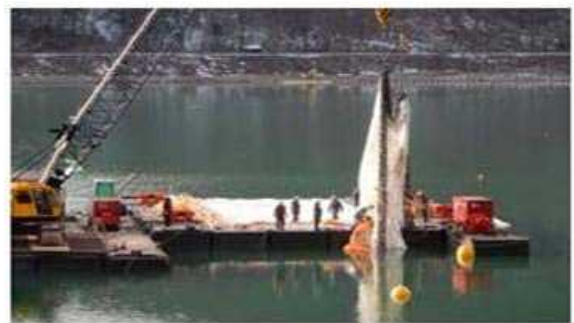
写真-3 沈下式汚濁防止フェンス
