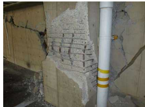
写真-4 柱の損傷 (X4-Y2柱)
