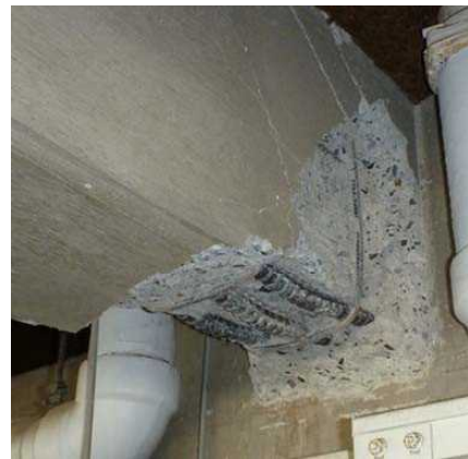
写真-5 梁端部の損傷 (X3-Y2柱に取りつく張間方向大梁)
