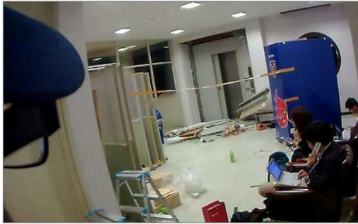
写真-3 ウェアラブルカメラで撮影した 益城町役場庁舎内の被災状況
