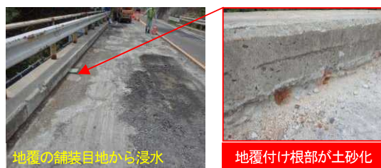
写真-12 舗装目地部のコンクリート部材損傷状況
