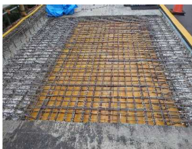
写真-7 フランジ上を残した床版打換
