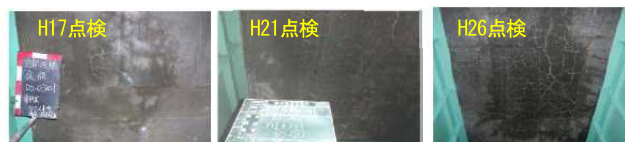
写真-2 橋梁点検による経年変化
