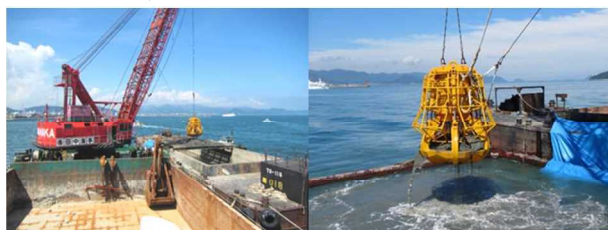
写真-2 海上での浚渫状況
