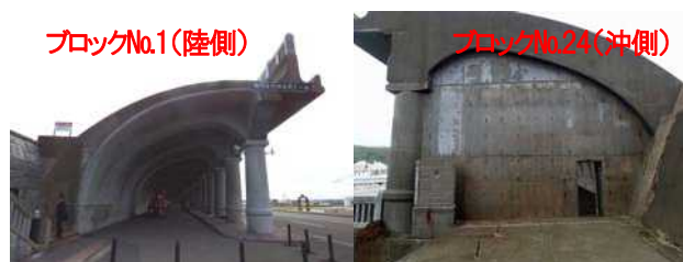
写真-8 北防波堤ドームの施設端部
