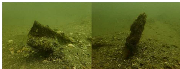
写真-4 潜水探査(確認)時の水中写真 (鋼矢板(左)、鉄パイプ(右))
