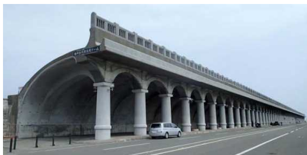
写真-1 北防波堤ドーム全景
