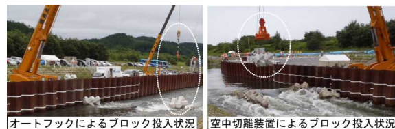
図-3 ブロック投入方法
