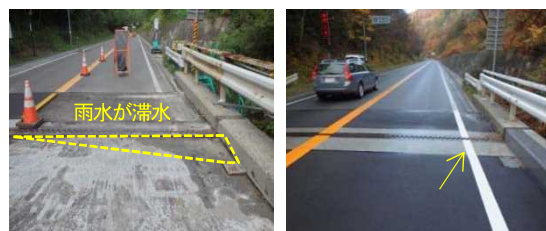
写真-13 排水柵直近の構造改善事例
