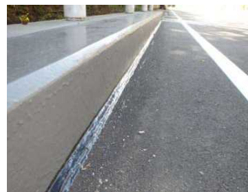
写真-11 高性能防水設置状況
