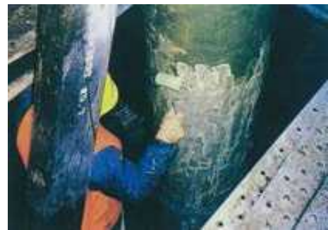
図-3 水中硬化形被覆の施工例
