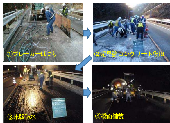
写真-5 前回即日復旧の補修状況
