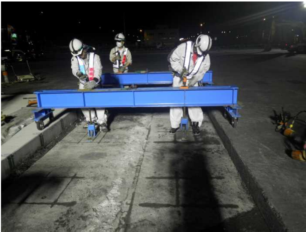
写真-8 油圧ジャッキを用いた地切り
