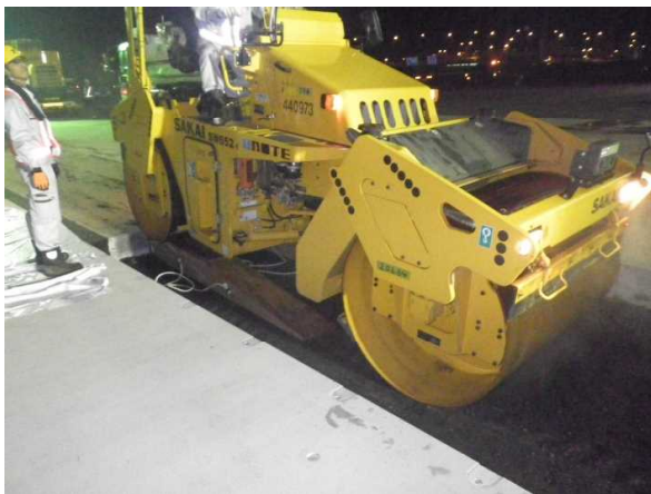
写真-9 段差解消スロープ
