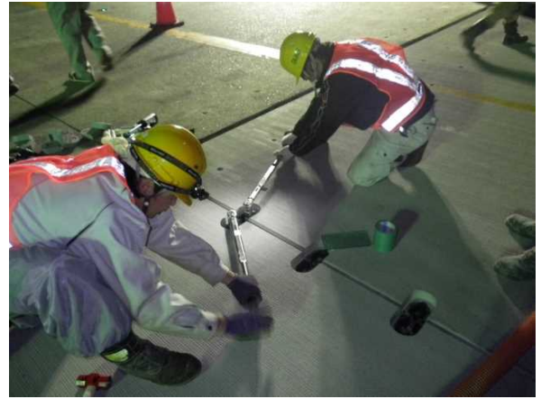
写真-7 コッター式継手仮締付け
