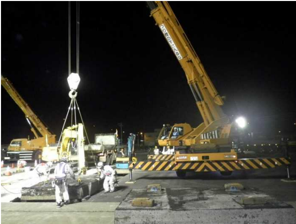
写真-5 既設コンクリート舗装版撤去
