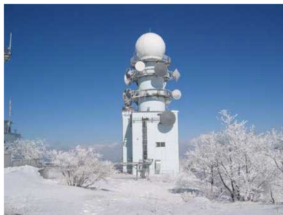
図-1 Cバンドレーダ雨量計(赤城山)
