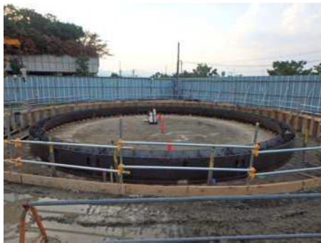
写真-2 刃口金物据付
