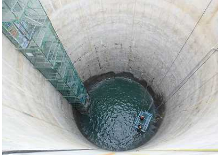
写真-7 壁面清掃
