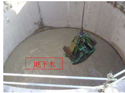
写真-9 オープンケーソン工法
