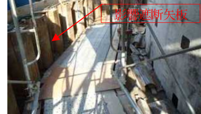
写真-10 影響遮断矢板
