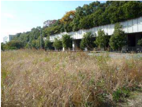
写真-1 発進立坑の施工場所
