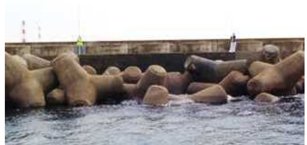
図-2 確認された天端高不足箇所
