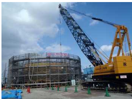
写真-3 足場・型枠組立
