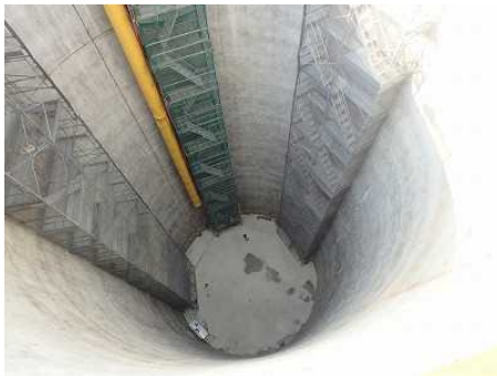
写真-8 発進立坑（完成）
