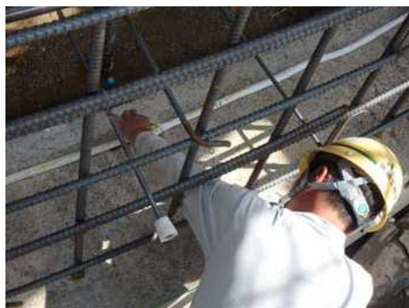
写真-14 ポリニットロープ施工状況
