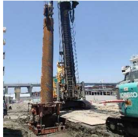
図-12 杭打設状況
