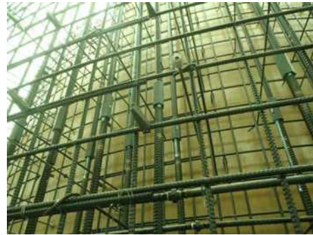
写真-4 鉄筋組立
