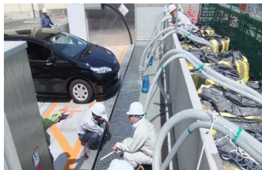
図-17 車両を載せての起立確認試験
