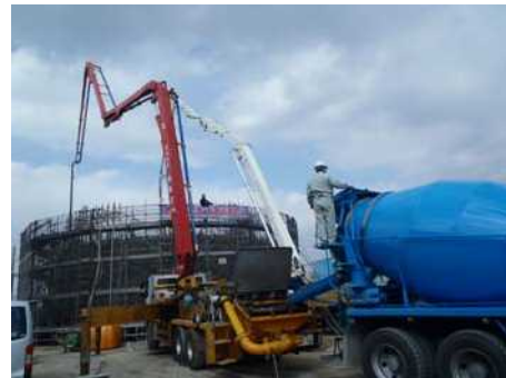
写真-5 コンクリート打設
