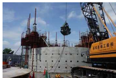
写真-6 掘削・沈下
