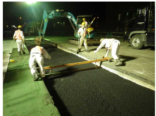
写真-10 上層路盤仕上げ用高さ調整器具
