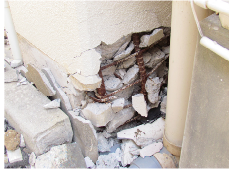
写真-7 渡り廊下棟の1階柱の柱脚
