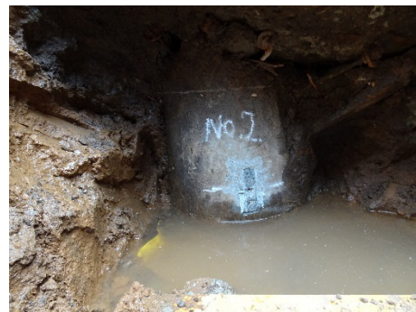
写真-9 No.2(X1-Y4)の杭頭部の状況
