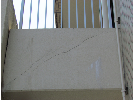
写真-5 外フレームと既存部の境界梁
