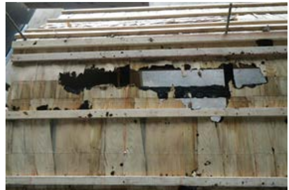
写真-6 棟部で屋根下地（巻木端）が燃え抜けた例
