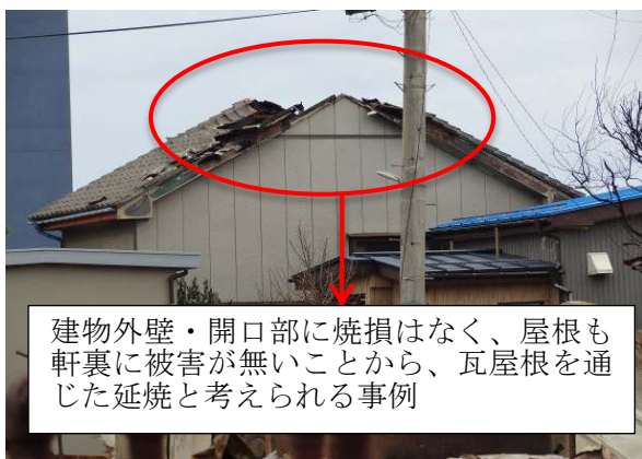
写真-2 瓦屋根の飛び火による延焼事例
