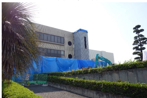
写真-1 建築物北東のエレベータ棟と鉄骨造の庇
