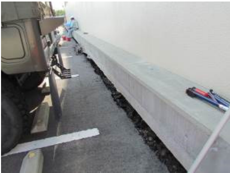
写真-6 建築物南側の地盤変状
