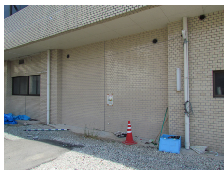
写真-2 損傷度Iの両側柱付壁
