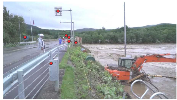
図-6 標定点の設置
