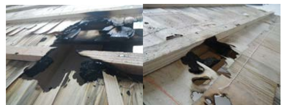
写真-7 瓦棧付近で燃え抜けた例
