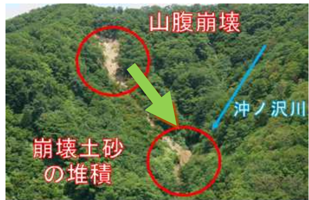
図2—山腹崩壊全景(ドローンによる空撮)
