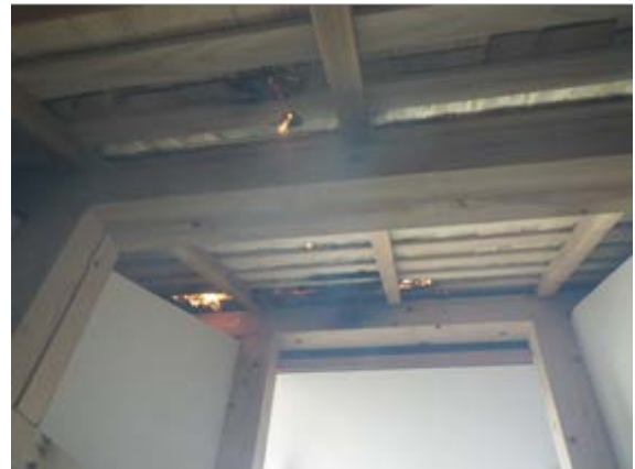
写真-5 実験中の屋内側の状況
