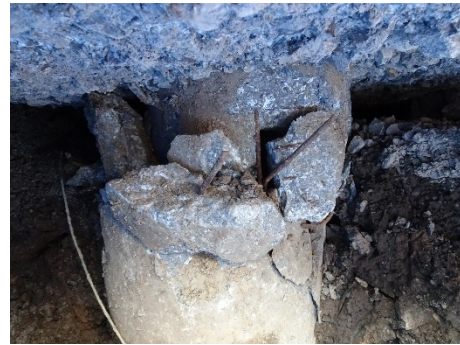
写真-8 No.1(X2-Y1)の杭頭部の状況
