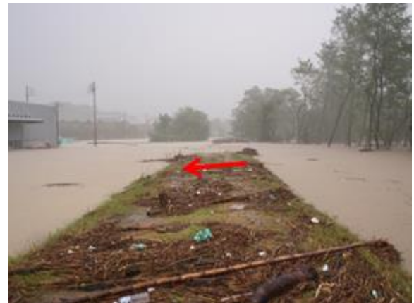
写真-1 H23台風15号による志段味地区越水箇所
