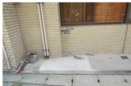
写真-3 腰壁の損傷
