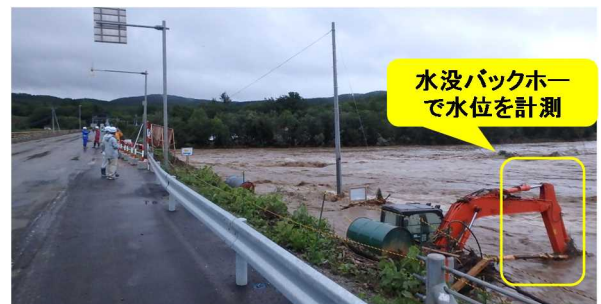
図-5 水位測定：バックホー (8月31日5時頃)
