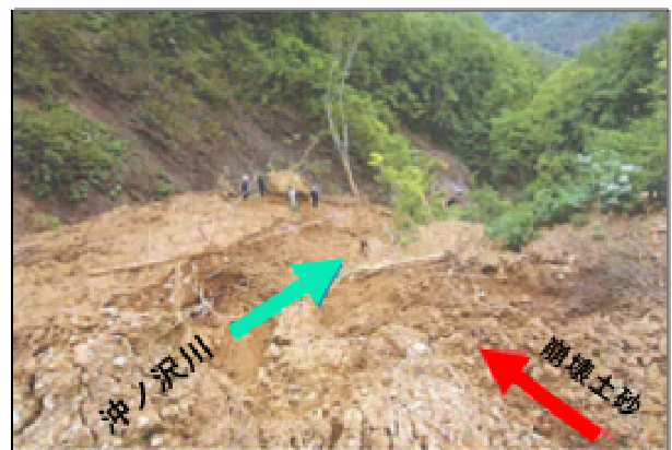
図3—上流域土砂堆積状況
