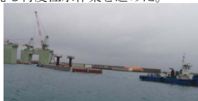
写真8. カルバートより進水引出中
