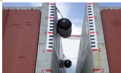
写真 12. 空気式防舷材敷設状況
