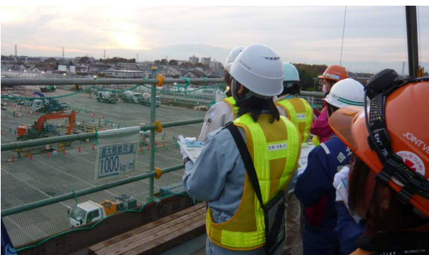
図-7 安全通路の現場点検状況
