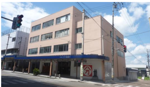
写真-11 施設の外観
