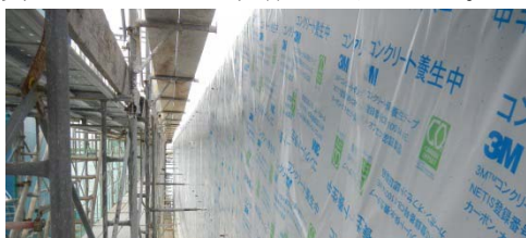
写真7. 保水養生テープによる養生
