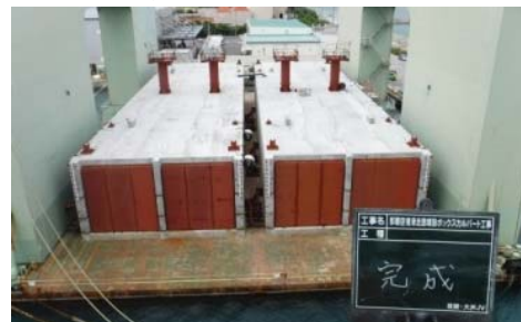
写真3. ボックスカルバート完成写真
