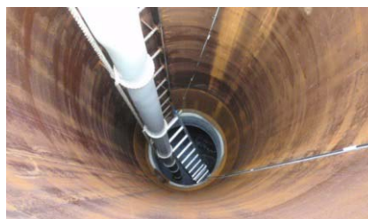
写真9. アクセスシャフトより注水作業
