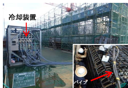
写真6. パイプクーリングシステム
