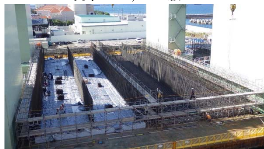
写真2. 12,000t級FDでの製作状況(鉄筋組立)
