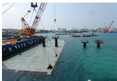
写真10. 注水作業中 (右側は水中仮置き中のカルバート)
