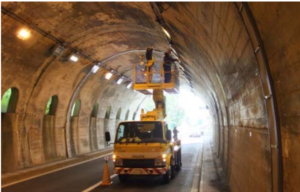
図-1 近接目視作業の状況
