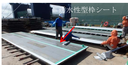
写真5. 透水性型枠シート貼付状況
