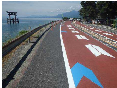
図-4 自転車通行帯整備事例（国道161号、矢羽根型路面表示）
