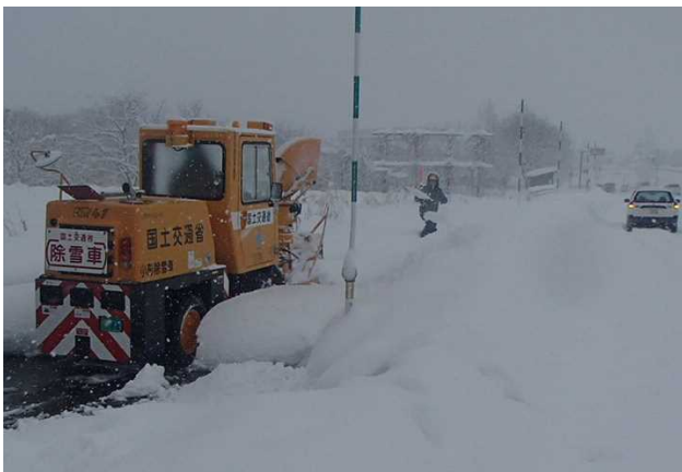
写真-4 歩道除雪作業状況
