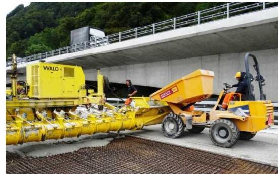
写真-1 海外での施工事例
