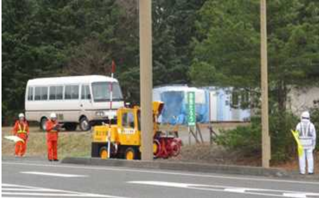
写真-3 障害物・投雪禁止区間登録状況
