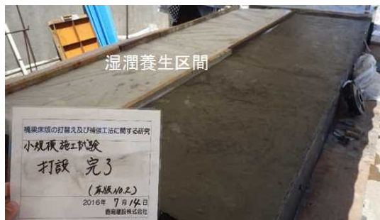
写真-2 初期養生の状況（床版No.2）
