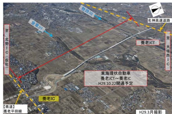
写真-1.養老JCT～養老IC区間斜め写真
