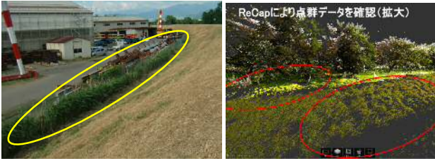
図-8 区間3川裏法尻部 図-9 区間5点群データ
