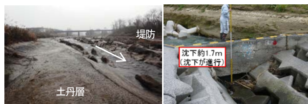
図-2 土丹層の露出状況
