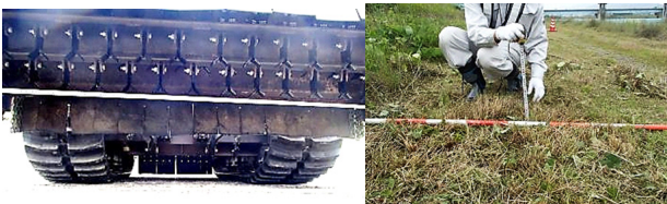
写真-6 刃先形状加工時の試験施工状況
