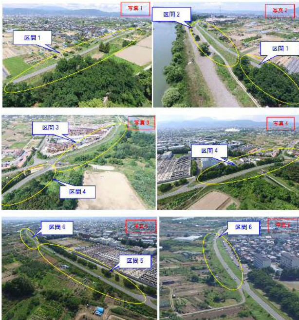
図-5 UAV撮影写真 (区間1:下流→区間6:上流)
