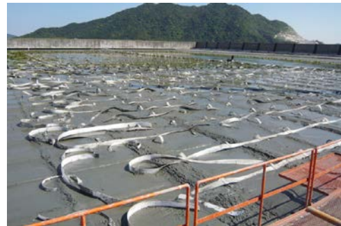
写真-2 ドレーン打設の様子
