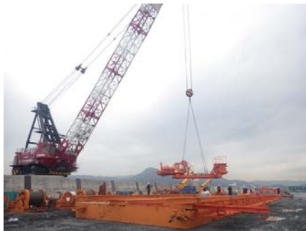
写真-1 ドレーン船搬入
