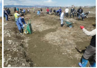
図-20 根茎土の運搬・敷設
