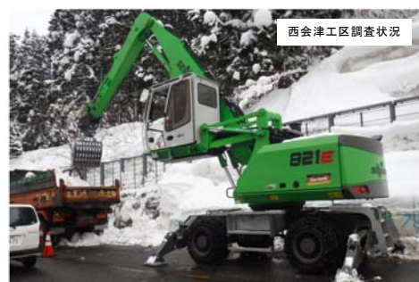
写真6 擁壁手前の積雪除去作業(選定機)
