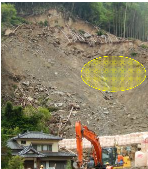
図-8 崩落斜面（○：点密度が低かった箇所）
