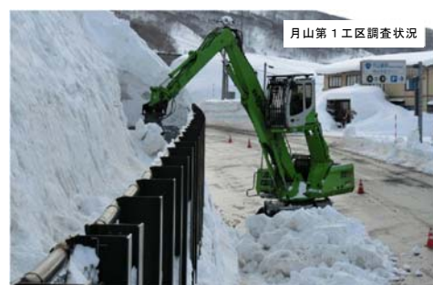
写真5 防雪柵背面のポケット造成作業(選定機)
