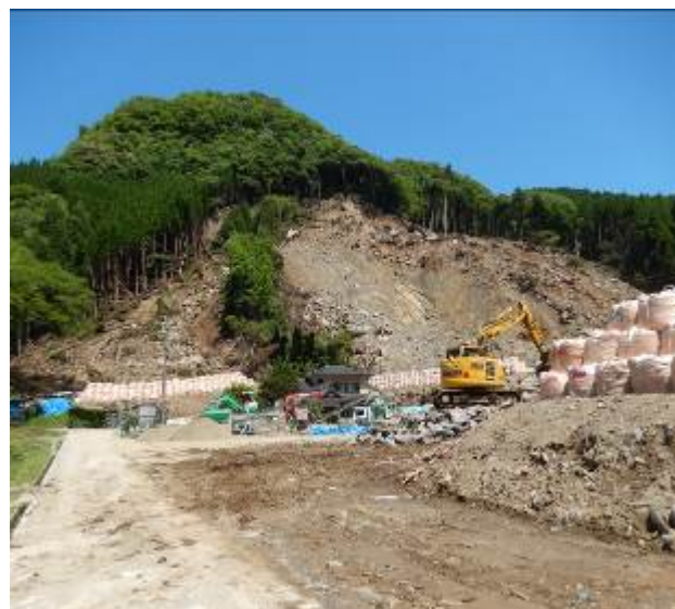
図-2 土砂崩落発生斜面
