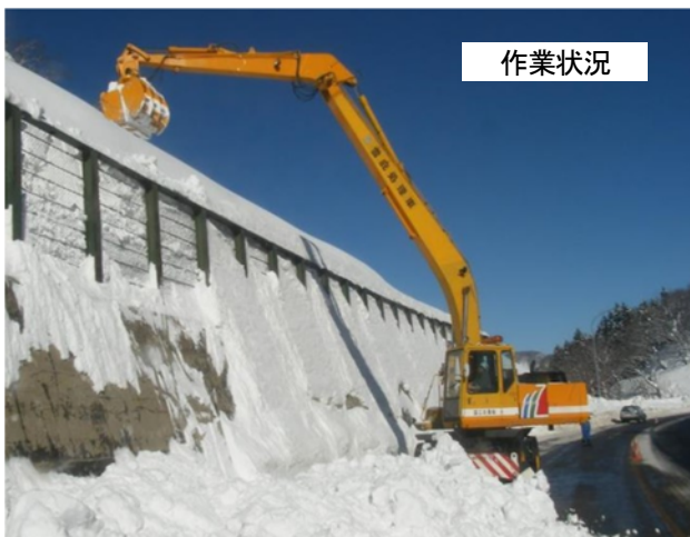
写真1 雪庇除去作業状況
