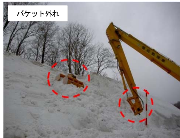
写真2 不具合状況①
