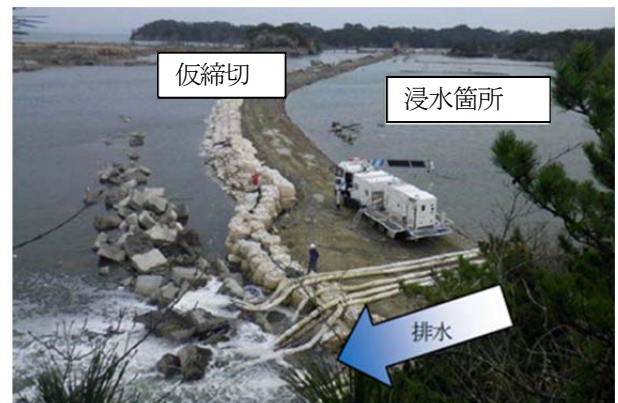
写真-1 東日本大震災での排水作業状況
