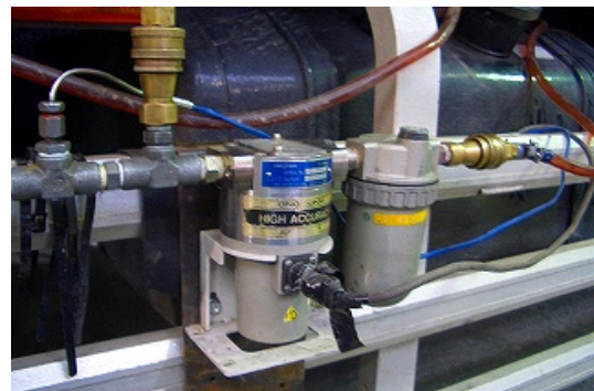
写真-2 燃料タンク脇に設置した燃料流量検出器
