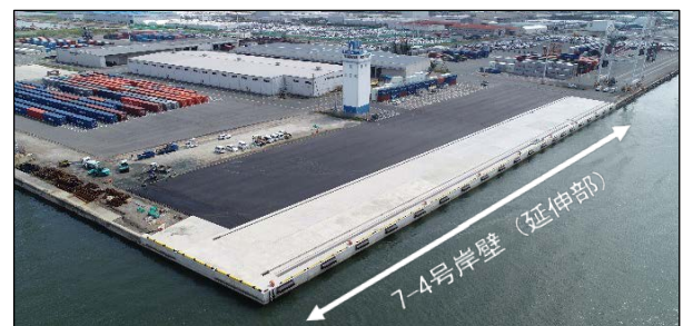
写真-1 完成した耐震強化岸壁
