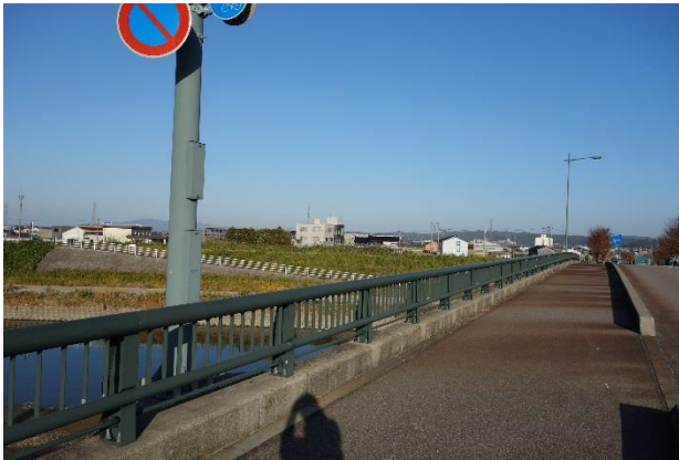
写真-3 防護柵と照明柱の色彩が違う例（上）および色彩の統一を図った例（下）
