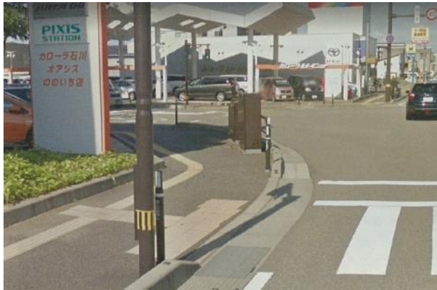
写真-6 視線誘導標を他の道路附属物の色彩とそろえた例
