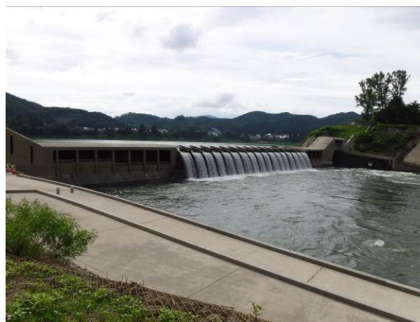
図2 湯田貯砂ダム全景
