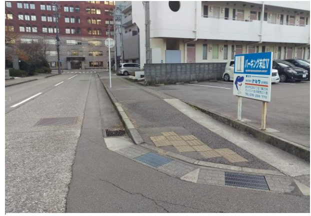
写真-7 平坦部が確保された歩道乗り入れ部の例
