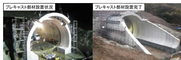
図-7 俵山トンネル熊本側坑口部：施工状況
