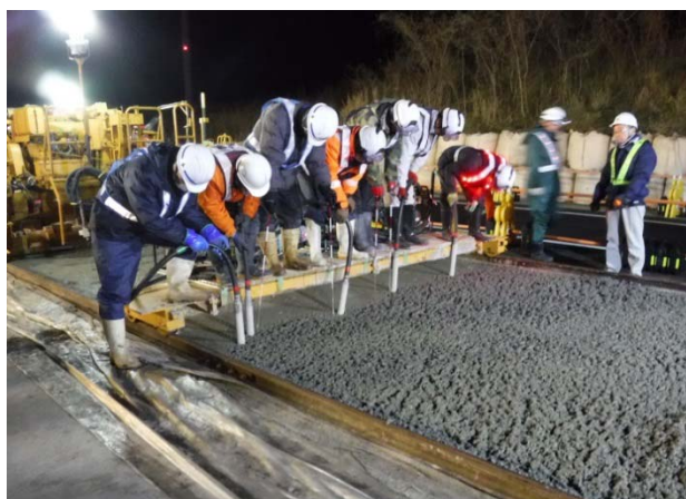
写真-3 バイブレーターを用いた人力による締固め
