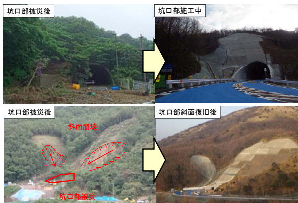
図-6 俵山トンネル熊本側坑口部：被災および復旧状況
