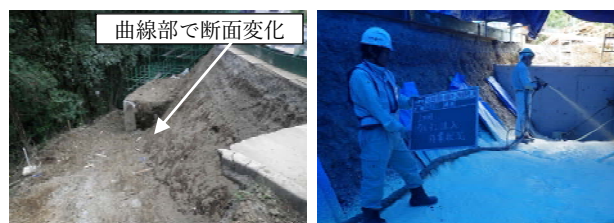
図-13 R-PUR工法施工状況
