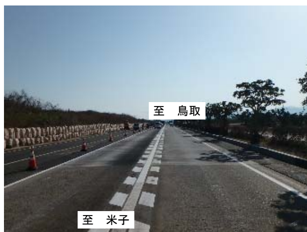
写真-2 北条バイパス復旧完了後
