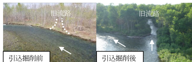
写真-2 H工区旧流路引き込みの状況
