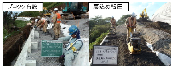
図-5 ラップブロック施工状況
