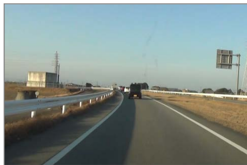
写真-3 バイパスの沿道状況
