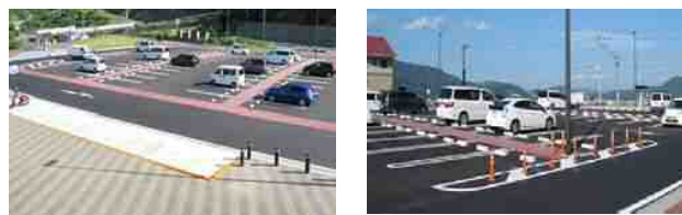
図-8 段差のカラー化、駐車場端部の見直し状況
