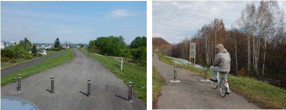
写真-5 車止めの設置イメージ写真
