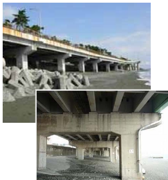
写真-1 耐震補強対象橋梁(補強前) 西湘バイパス
