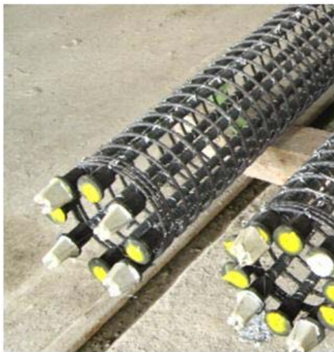
写真-4 高強度せん断補強筋の配筋状況
