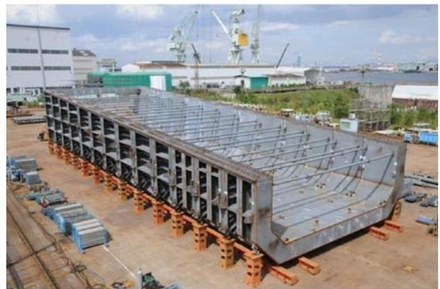
写真-1 工場仮組立状況（増設側1, 2号）
