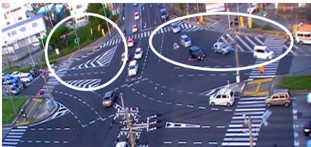
写真4 巻き込み半径が大きく左折車が高速で走行
