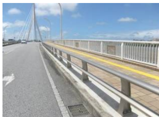
写真-2 防護柵工事事例
