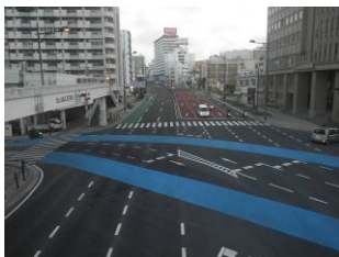
写真-1 滑り止め舗装工事事例
