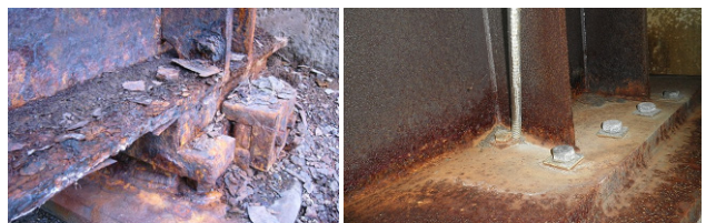
(a) 支承周辺
