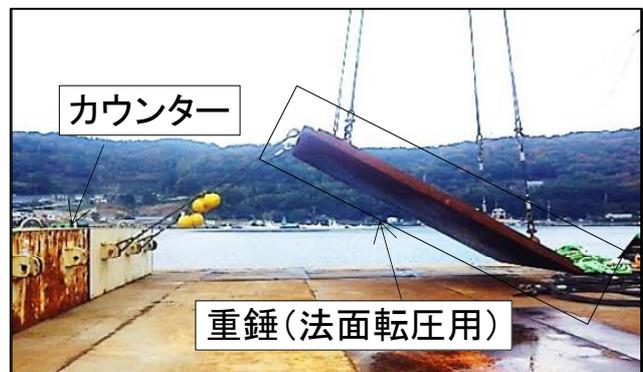
写真3 重錘（平面転圧用・法面転圧用）
