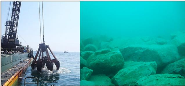
写真2 ガット船による石材の投入状況
