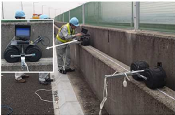
写真-2 橋上での作業状況
