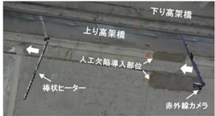
写真-3 張出床版下面での計測状況
