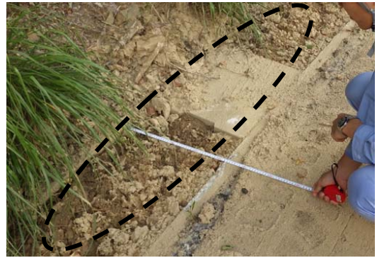
写真9 側溝の閉塞
