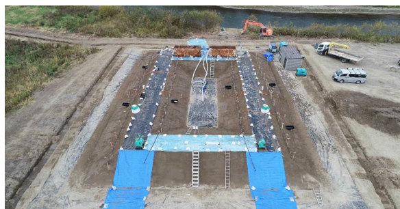
写真-2 実物大の試験堤防
