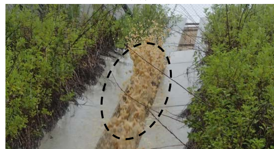
写真11 縦側溝越水の確認
