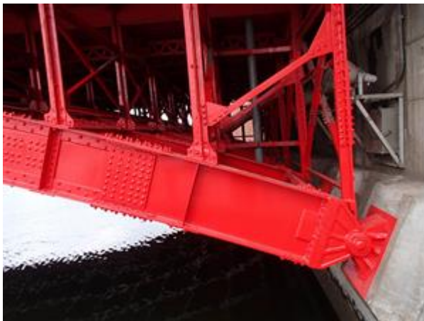
図-11 アーチリブ取替完了
