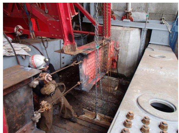
図-6 既設アーチリブ撤去状況
