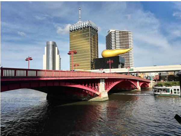
図-1 吾妻橋全景（隅田川下流右岸から望む）
