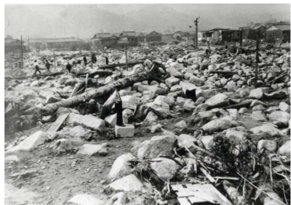
写真1 昭和13年 都賀川阪急北側付近被災状況
