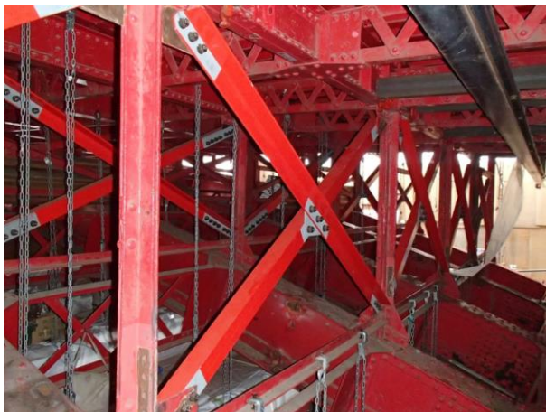
図-4 桁下鉛直材・補強材
