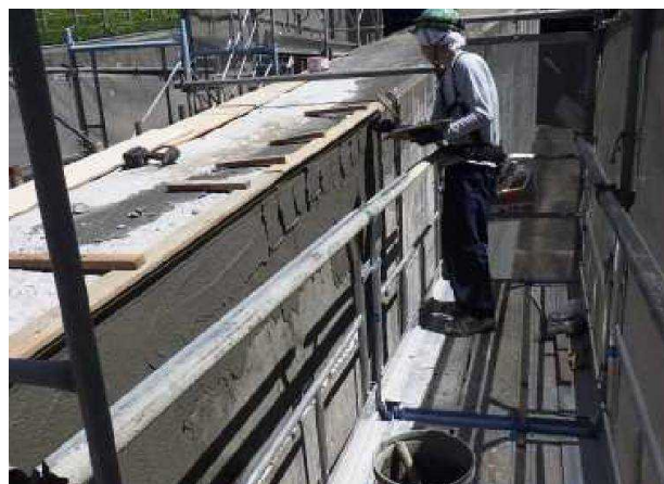
写真-5 充填工法
