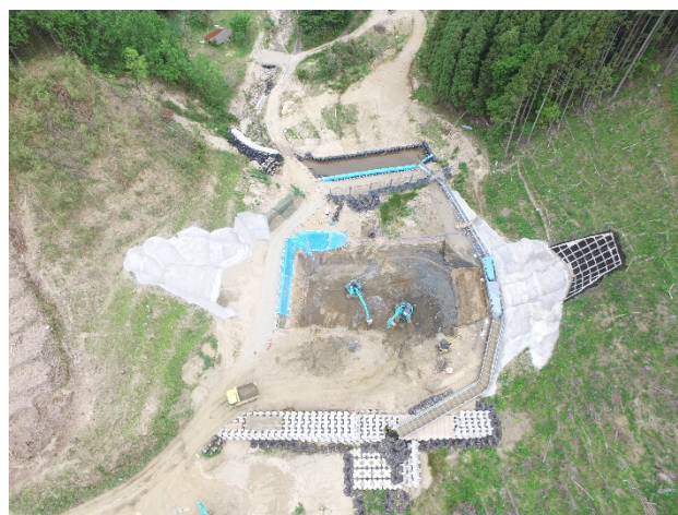
写真-5 整備が進む崩谷川砂防堰堤 (R1.5撮影)
