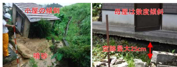
図-5 左：小屋の傾倒・噴砂状況 右：母屋の被災状況
