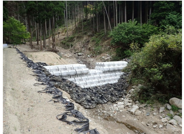
写真-3 乙石川の溪流で施工した仮設堰堤（応急対策）
