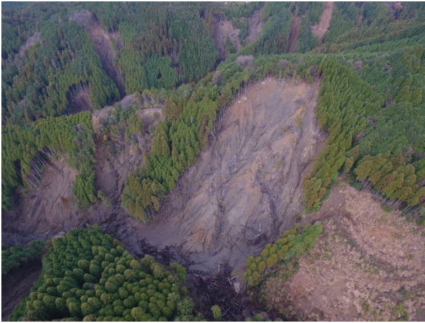
写真-2 汐井谷で発生した大規模斜面崩壊 (H30.12撮影)
