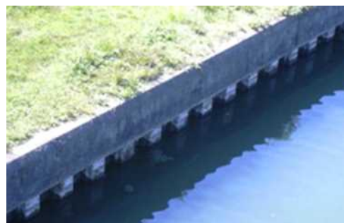
図-3 野洲川河口部の矢板護岸
