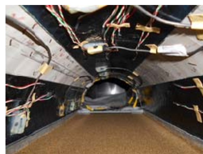
写真-9 補強状況
