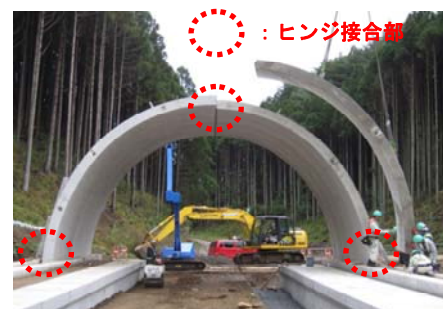
写真-1 施工時の3ヒンジアーチ
