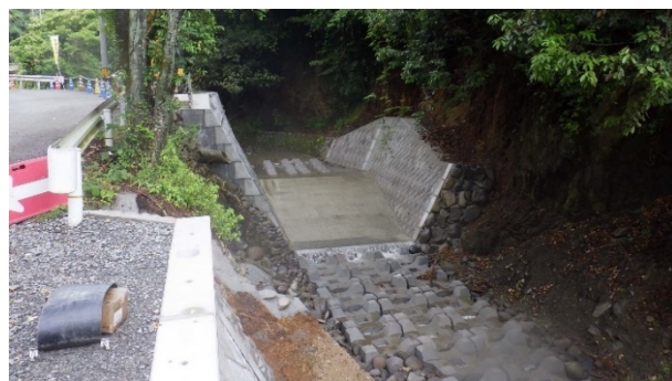
写真-1 原形復旧の様子
