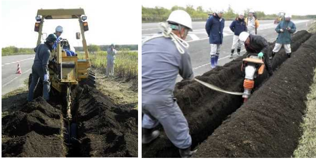
写真4 発生土の堆積状況
