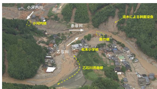
写真-3 三川合流部
