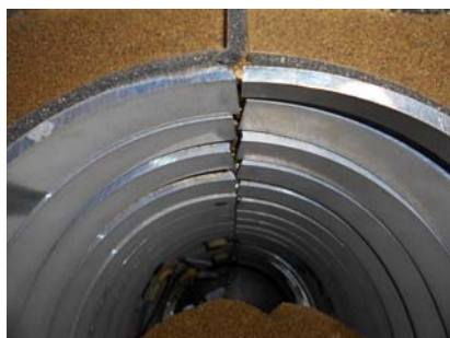
写真-10 CASE-1 加振後の内部状況
