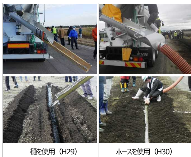
写真-2 流動化処理土の施工状況
