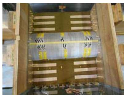
写真-8 帯状補強材の配置状況
