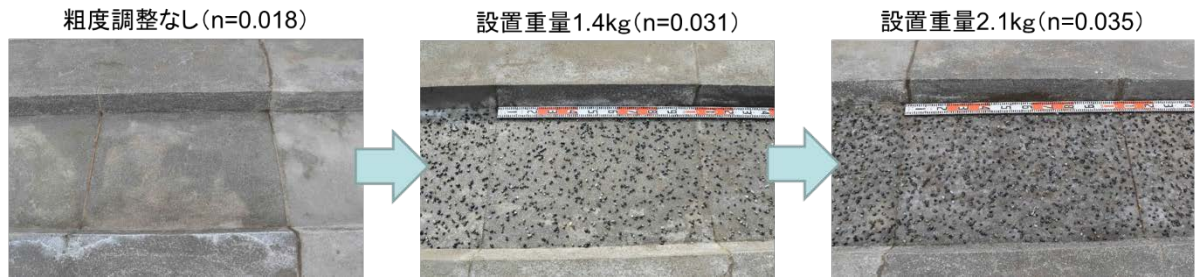
写真-6 粗度調整の様子
