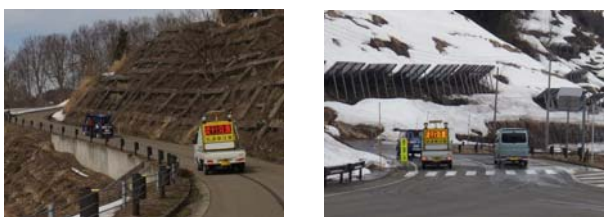
図-11 一般車とのすれ違いの様子
