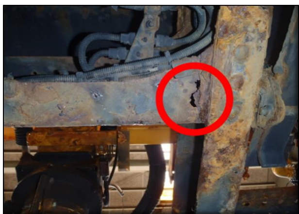
図-2 シャシ後部サブフレーム穴あき状況
