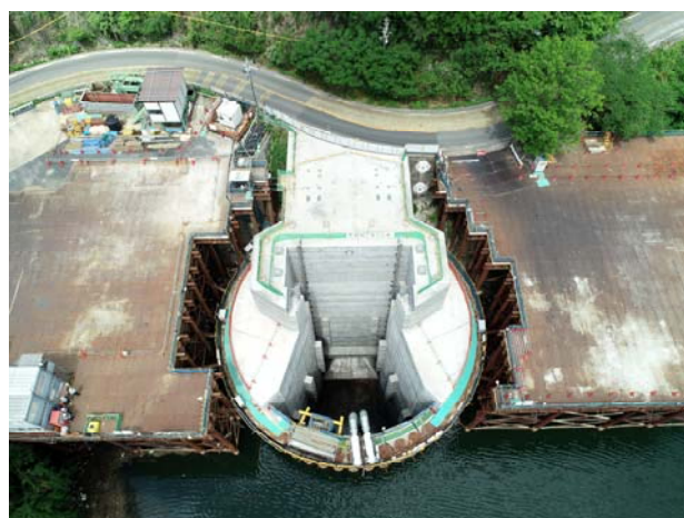
図-5 流入部の施工状況（2019年6月）
