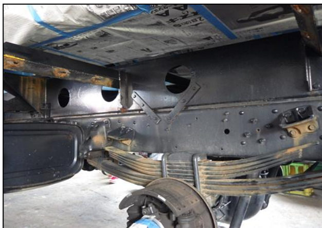
図-6 塗料B シャシフレーム外側状況
