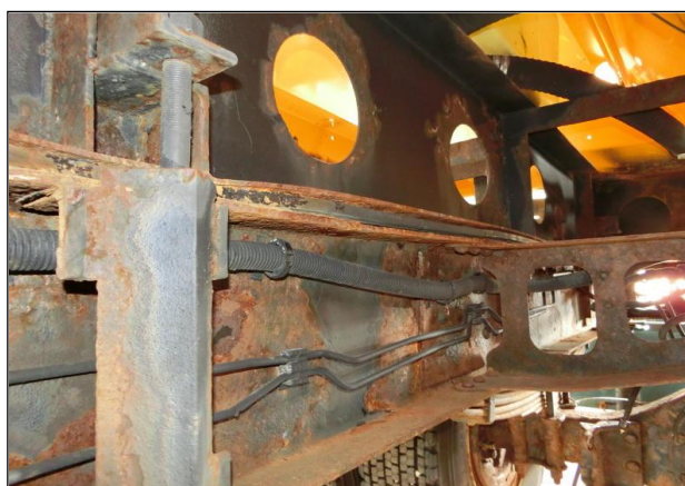
図-1 シャシフレーム内側状況
