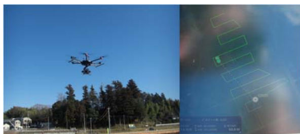
図-6 UAV 測量状況
