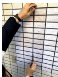
写真-4 ひび割れの再現方法 （上：使用したパネル， 下：ひび割れの調整状況）
