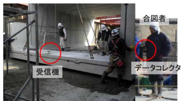
図-9 カルバート据付状況
