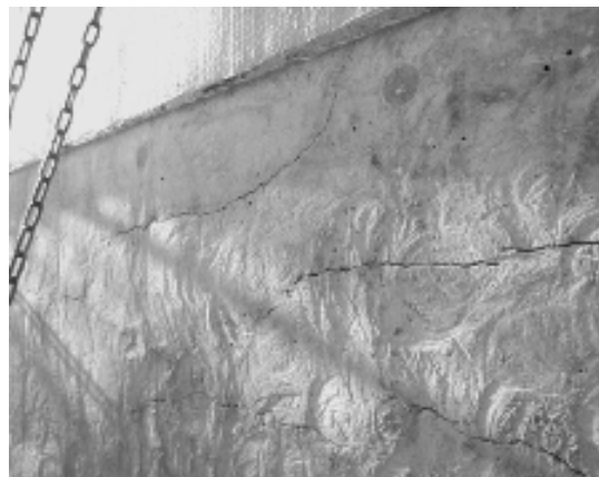
写真-11 はく落防止対策撤去後のひび割れ
