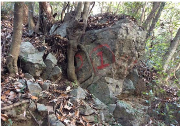
d) 12番の箇所状況 (高さ2.4m)
