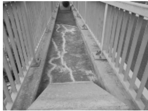
写真-3 PC桁上面の変状
