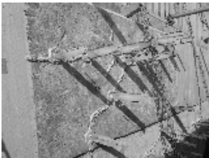
写真-7 ひび割れ注入 (エポキシ樹脂系)
