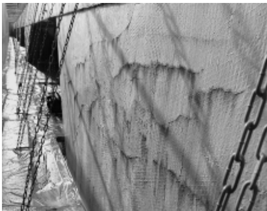
写真-10 はく落防止対策部の塗膜の汚れ
