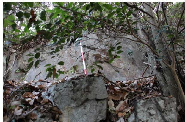
b) 3番の箇所の状況 (高さ1.6m)
