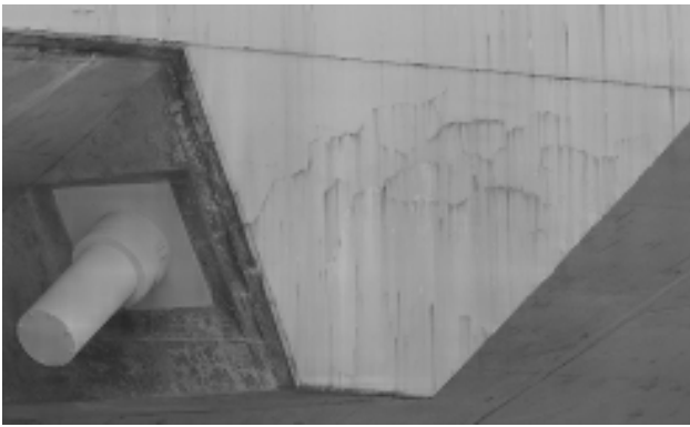
写真-2 PC桁側面の変状
