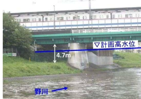
図-4 既設橋梁による堤防高の制約
