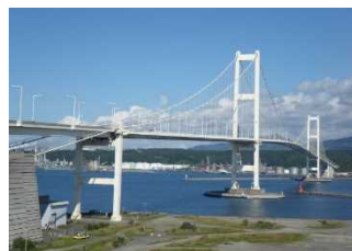
写真-1 白鳥大橋
