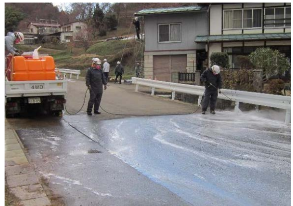
図-5 道路除染状況(高圧洗浄)
