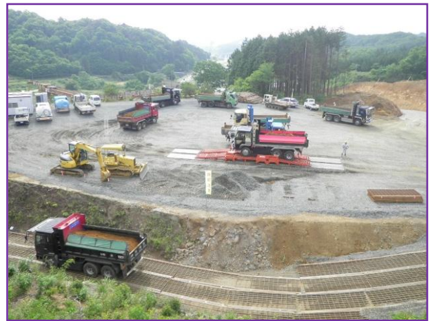
写真-15 計画策定後の場内ルート状況
