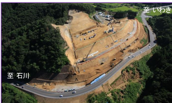
写真-9 第1段階の供用状況 (2012年8月)
