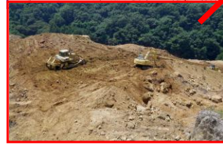
写真-5 頭部排土状況
