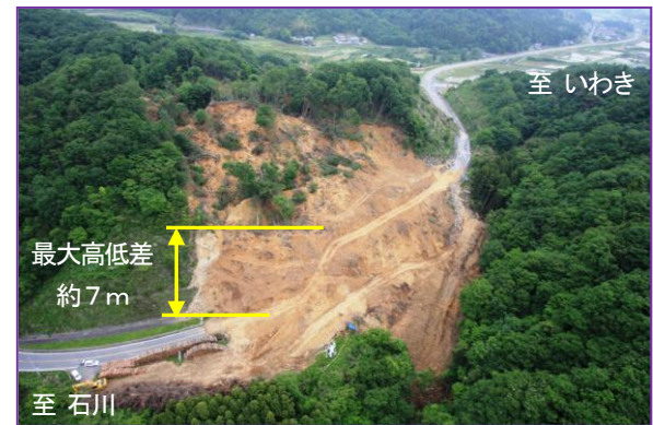
写真-6 準備工（倒木処理）完了状況
