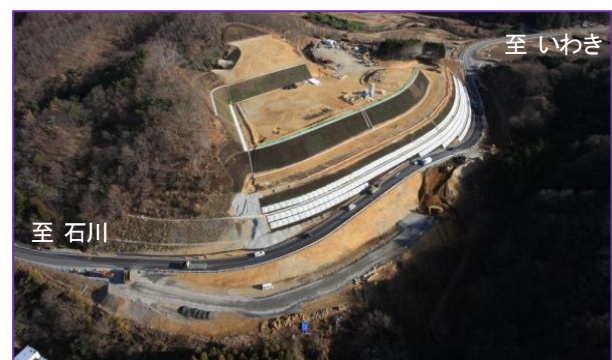
写真-10 第2段階の供用状況 (2012年12月)
