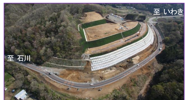
写真-12 第3段階の供用状況 (2013年3月)
