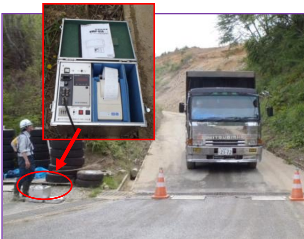
写真-16 トラックスケールの設置
