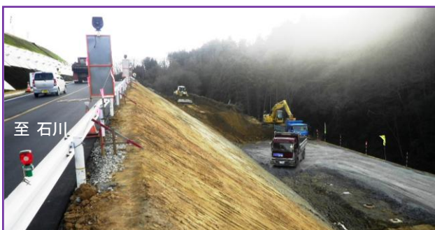
写真-11 第2段階から第3段階への施工状況
