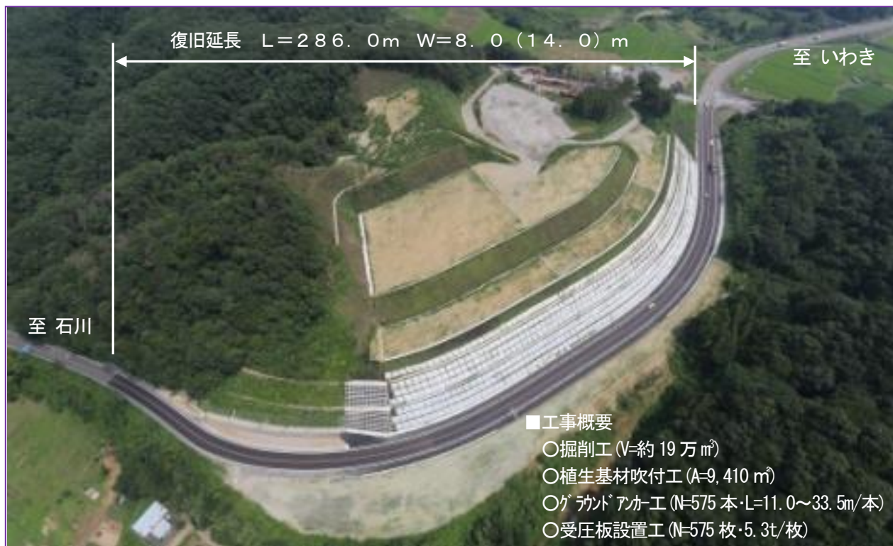
写真-21 本復旧工事完成 (2013年8月28日)
