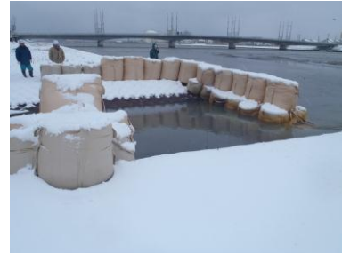
写真3 仮設工の事例（堤外水路閉塞防止工）
