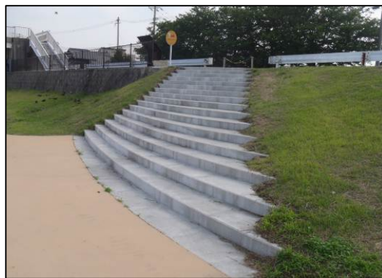
写真5 階段工完成写真
