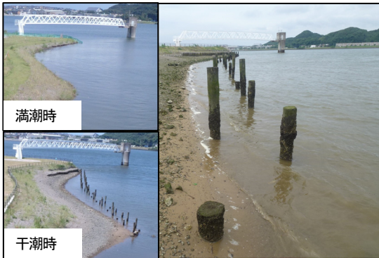
写真8 干潟杭の設置
