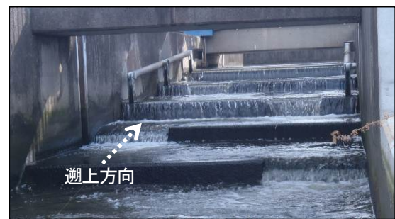
写真1 既設の階段式魚道
