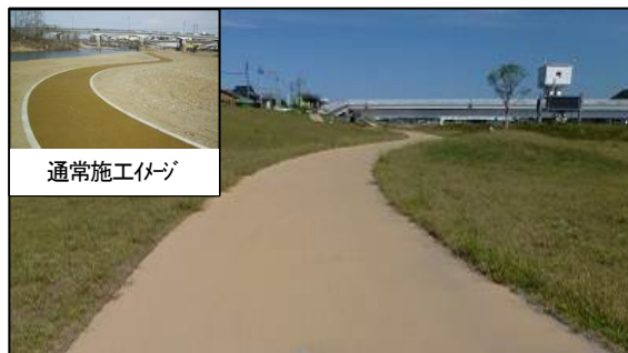
写真6 見切材を使用した舗装
