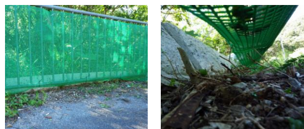
写-11 フェンス下部開口部対策
