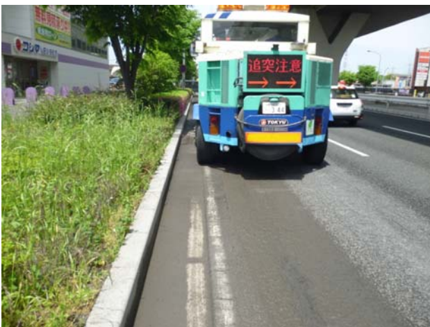
写真-6 都市型ブラシ式清掃車による清掃状況
