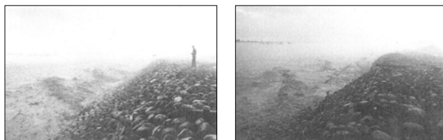
①南島堤護岸の洪水状況
