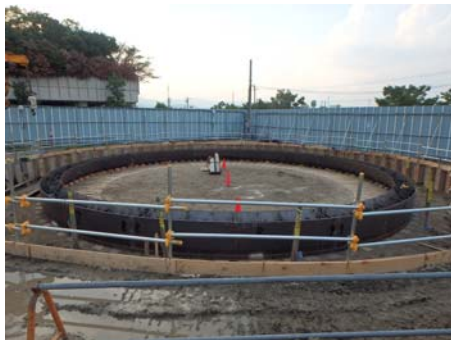
写真-2 刃口金物据付
