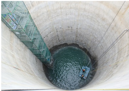
写真-7 壁面清掃
