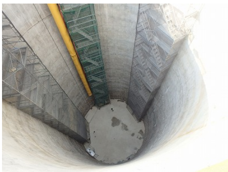
写真-8 発進立坑（完成）
