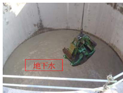
写真-9 オープンケーソン工法
