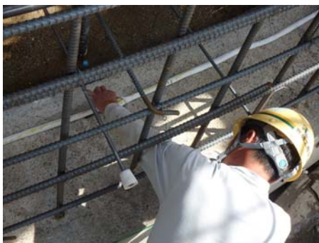
写真-14 ポリニットロープ施工状況
