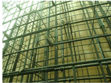
写真-4 鉄筋組立
