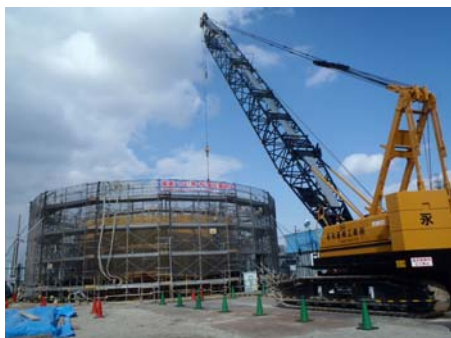
写真-3 足場・型枠組立
