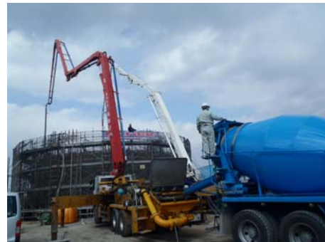
写真-5 コンクリート打設
