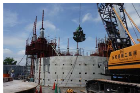
写真-6 掘削・沈下
