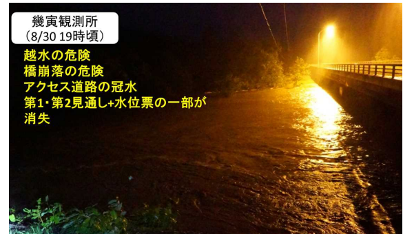
図-2 幾寅水位流量観測所の現地状況（8月30日19時頃）
