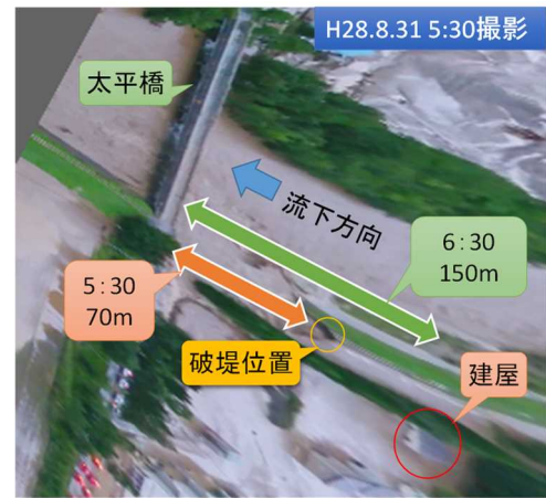
図-12 破堤長の変化
