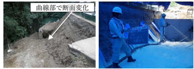
図-13 R-PUR工法施工状況
