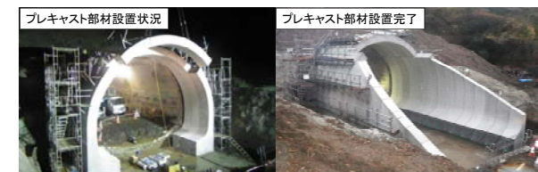
図-7 俵山トンネル熊本側坑口部：施工状況
