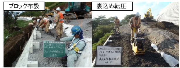
図-5 ラップブロック施工状況
