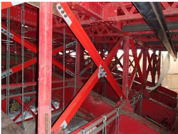
図-4 桁下鉛直材・補強材
