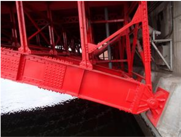
図-11 アーチリブ取替完了
