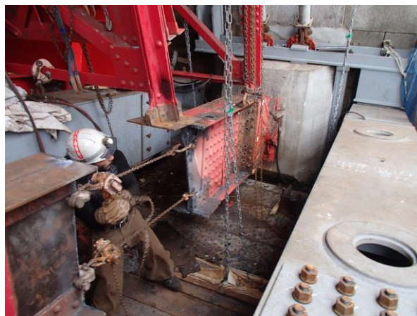
図-6 既設アーチリブ撤去状況
