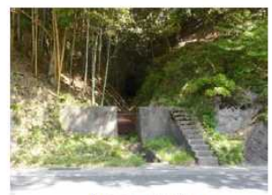
土砂流出対策工
