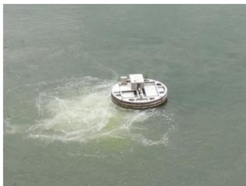
写真-1 曝気循環装置
