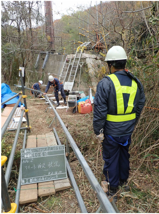
写真-5 東谷堰堤の現場状況
