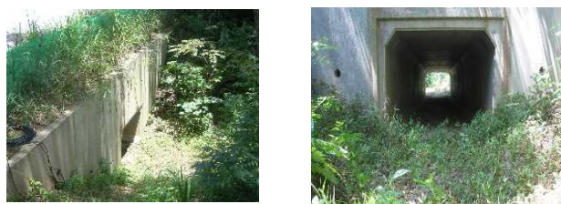
写-11 クイナトンネルの写真
