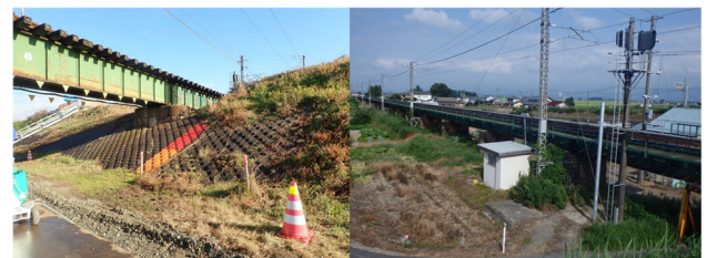
図-2 右岸堤防と堤内地の状況
