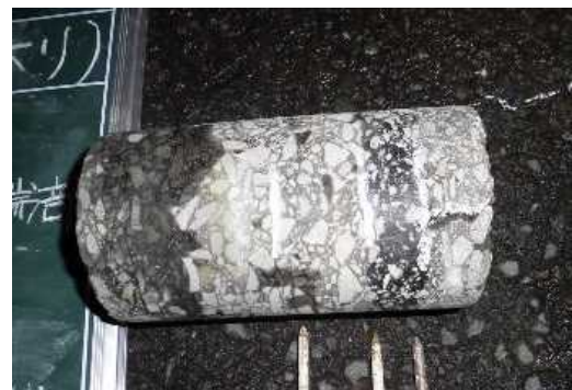
写真-4 コア写真 (ひび割れ端部)
