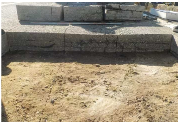
写真-5 路盤状況写真
