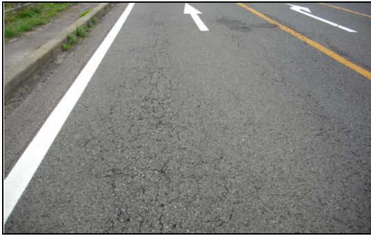
写真-1 現況写真 (国道7号にかほ市象潟大砂川地内)
