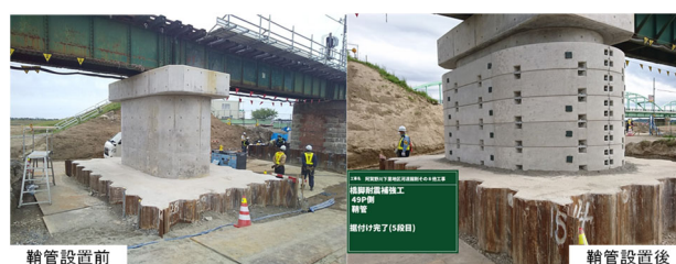
図-13 鞘管設置前後の状況
