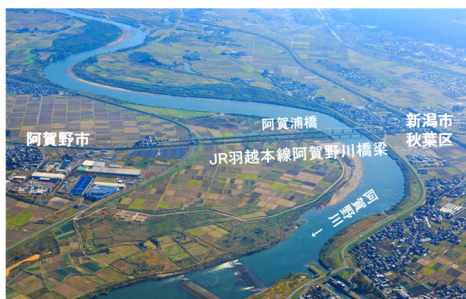
図-1 阿賀野川とJR羽越本線阿賀野川橋梁
