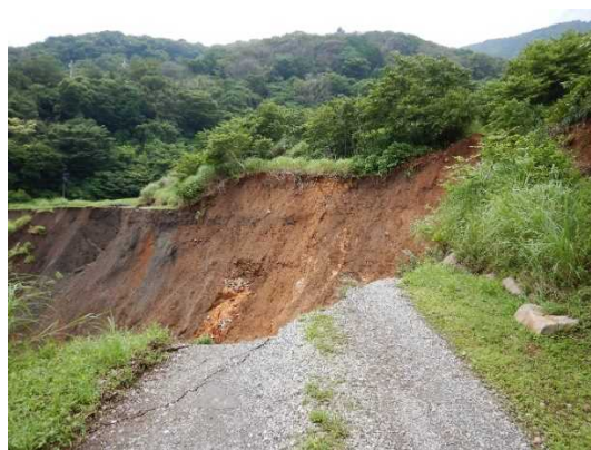
図-2 土石流源頭部
