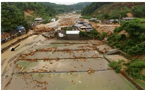
写真-1 赤谷川流域で発生した土砂や流木(H29. 7)
