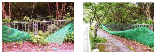
写-10 クイナフェンスの破損状況
