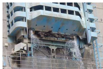
図-1 2017年裾花ダムゲートへの沈木集積状況
