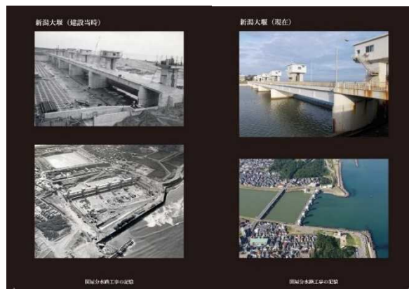
図-2 建設当時(左)と現在(右)の新潟大堰
