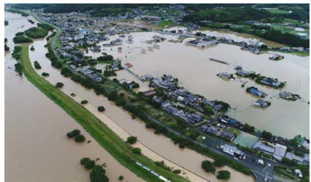
図3 芦田川流域(駅家町上山守地区)の内水被害の様子(出典:広島県IP「福山市域における浸水対策について~報告書~」より引用)
