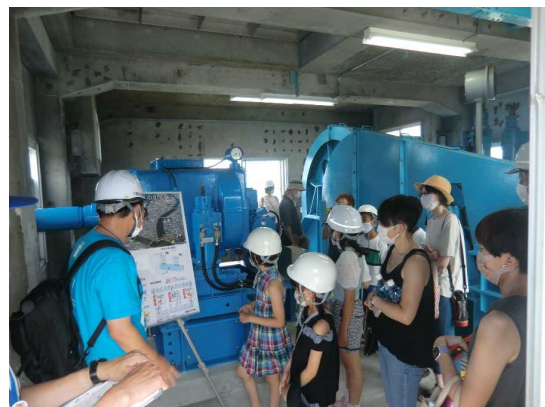
写真-7 新潟大堰特別開放
