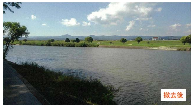
図9、10 羽賀橋撤去前と撤去後の様子
