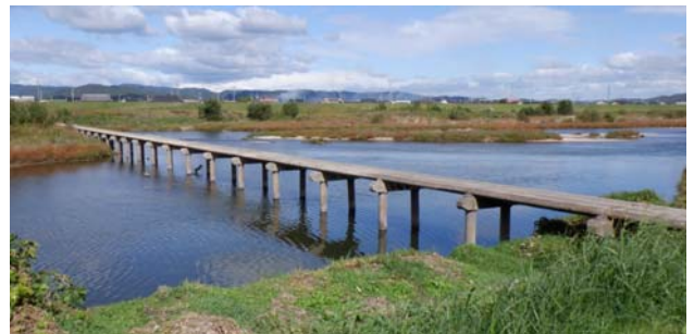
図2 平成30年7月豪雨で唯一流失を免れた下郷橋
