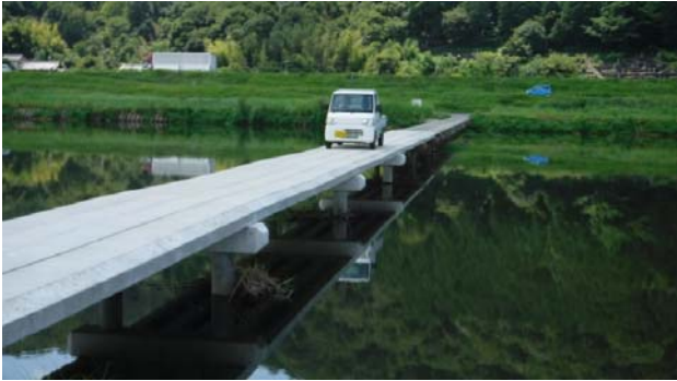
図11 復旧した下山守橋を通る地元車両（令和3年7月27日）
