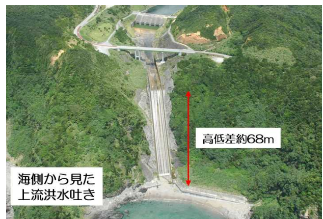
図-1 福地ダム上流洪水吐き
