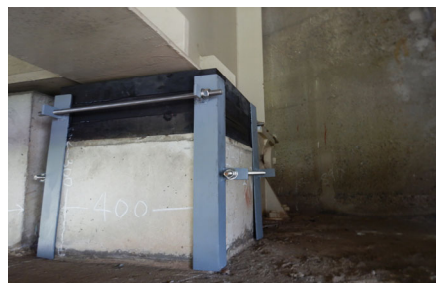
写真-11 緩衝ゴム設置
