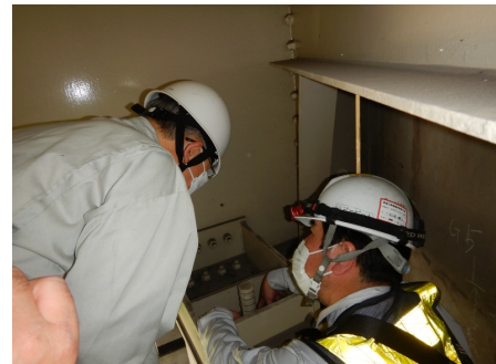
写真-8 合同現地調査状況
