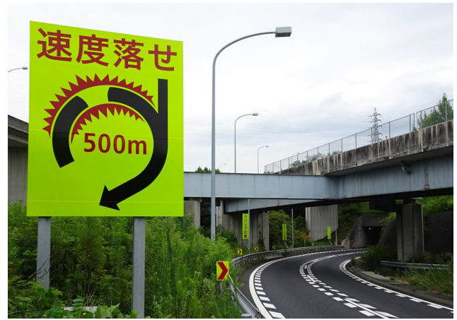
写真4 曲線入口部大型警戒標識
