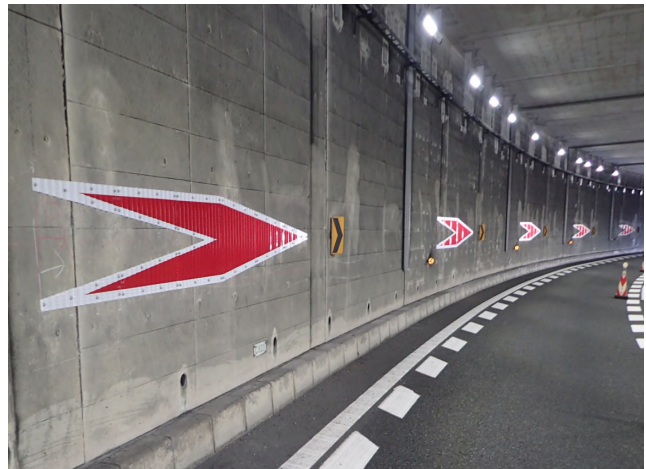
写真6 ボックスカルバート内 線形誘導標
