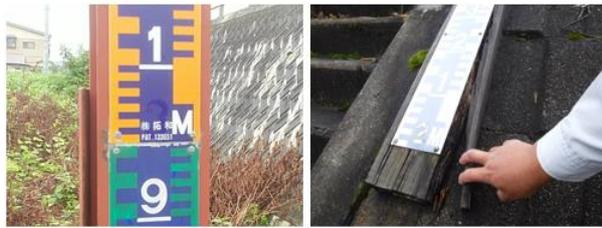
▲樋管の量水標の破損(読み取りに支障無し)
