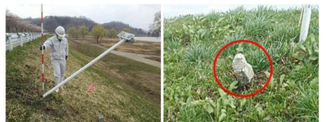
▲距離表示板や距離標杭の損傷
