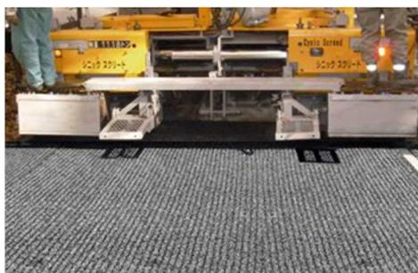
図-2 専用アスファルトフィニッシャーによる敷均し例
