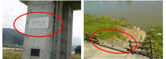
▲樋管の水位観測員退避水位の明示の劣化
