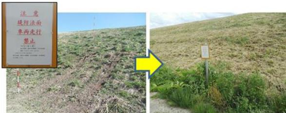
▲堤防の車両走行跡・轍掘れ(堤防に損傷無し)
