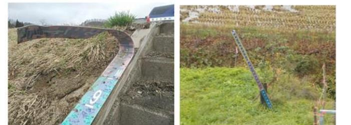
▲樋管の量水標の破損（読み取りに支障あり）
