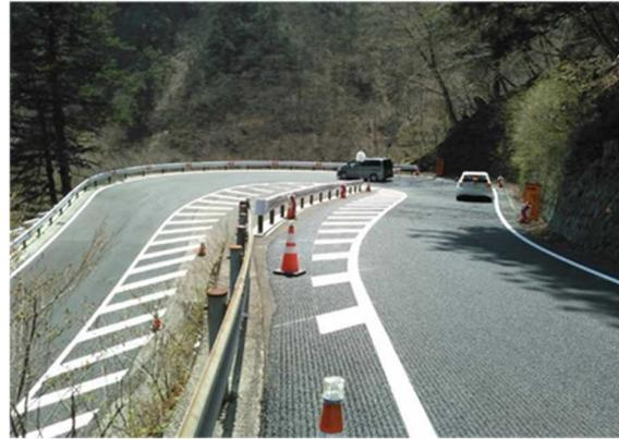
図8 FFP施工直後路面状況
