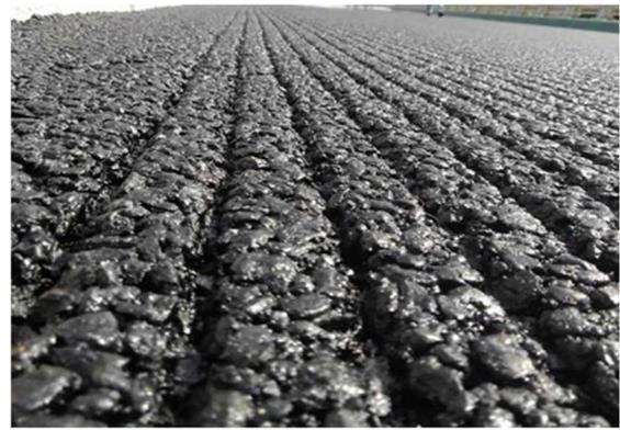
図-4 縦溝粗面仕上げ例
