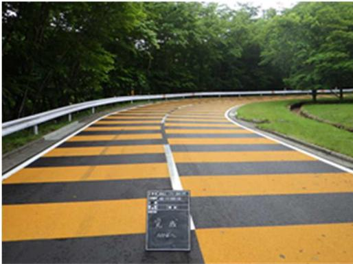
図6 薄層すべり止め舗装の施工例
