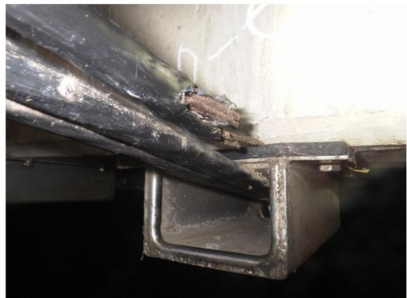
写真-2 外ケーブル損傷状況
