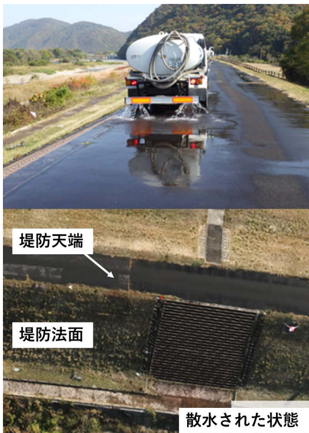
図-7 河川堤防を散水している状況と散水後の状態
