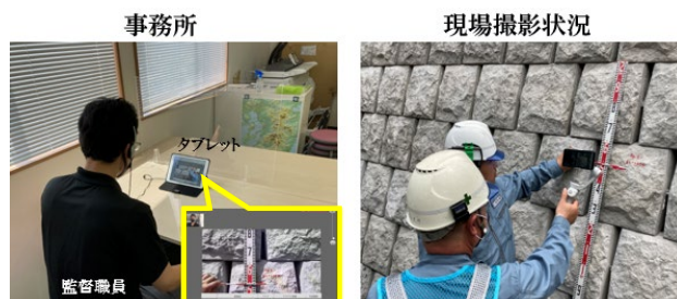
写真-1 遠隔臨場の活用状況（その1）
