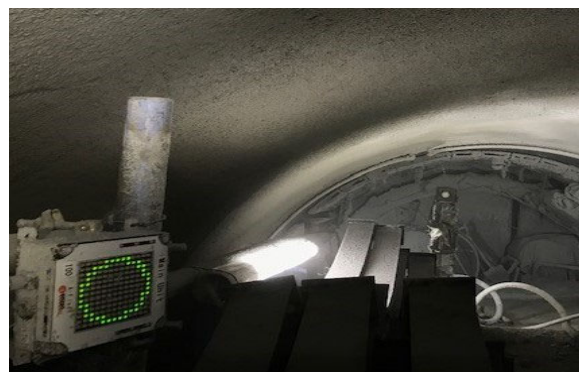
写真-2 警告ランプ設置状況
