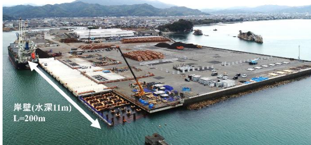
写真-2 金磯地区岸壁(水深11m)全景(2022.3撮影)
