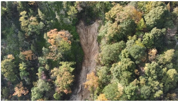
図-6 緊急詳細点検結果（崩壊地の特定）
