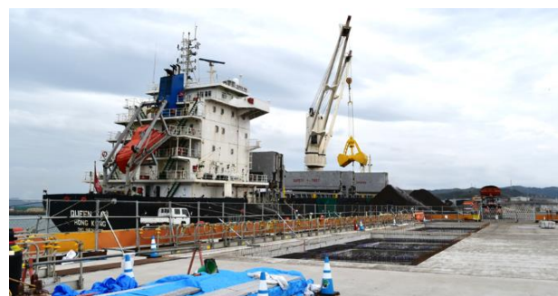
写真-7 工事中に荷役するPKS船
