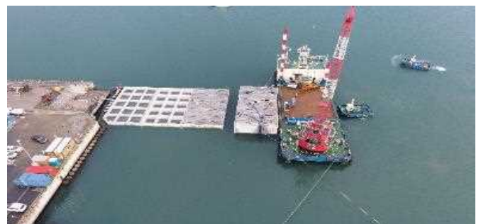
図-1 6 ケーソン据付状況
