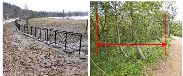
写真-2 左:イノシシ侵入防止柵、右:緩衝帯整備
