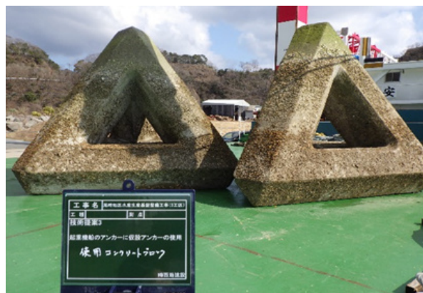
写真-4. 仮設アンカブロック
