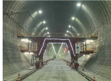
写真-1 移動式鉄筋足場台車
