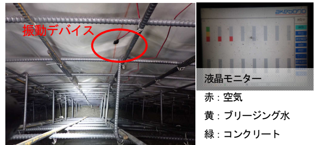
写真-3 覆工充填確認状況
