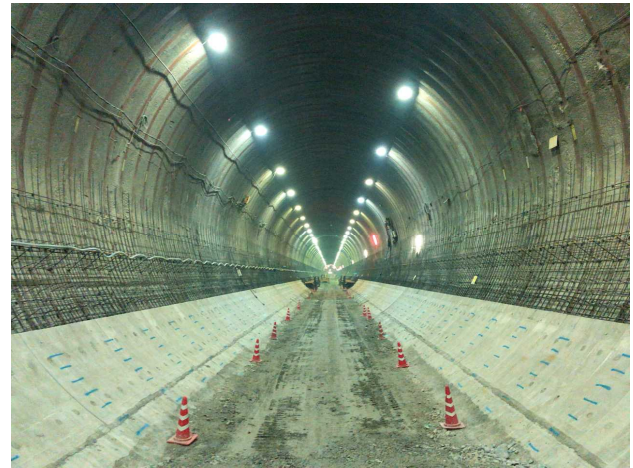
写真-2 インバート③打設完了全景
