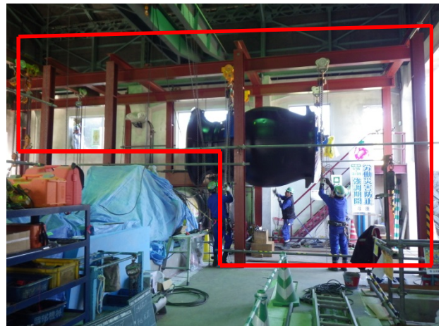
図-9 仮設門型クレーンによる主ポンプ搬入
