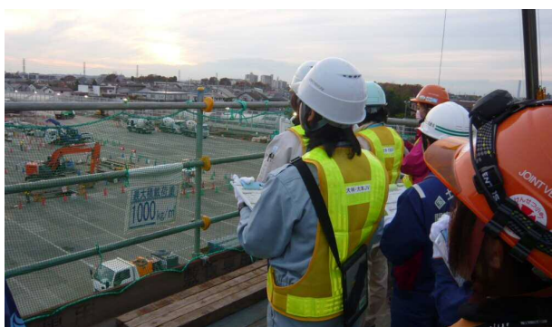
図-7 安全通路の現場点検状況
