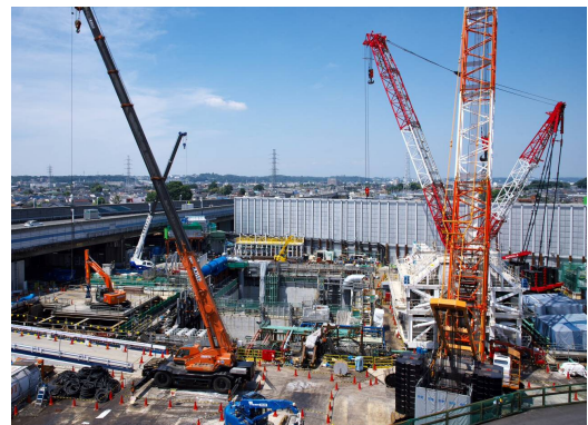
図-2 東名JCTの現場写真
