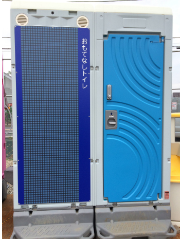
図-13 簡易水洗型快適トイレ
