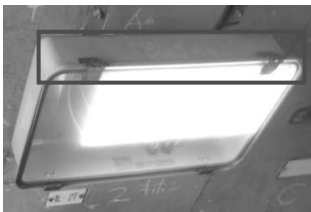
写真-1 確認箇所
